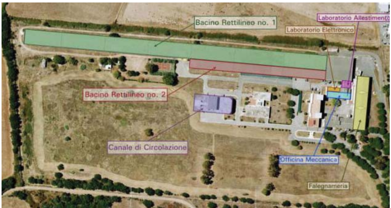
Vista dall'alto delle infrastrutture di prova della Vasca Navale di Roma nell'attuale sede di Vallerano (Fonte: inSean.cnr.it).
